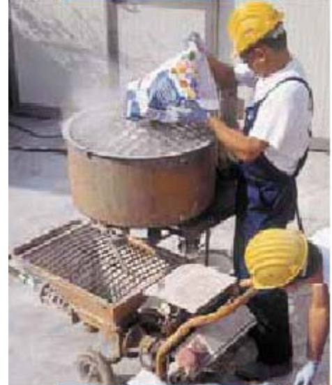
Замес перед подачей растворомасосом
