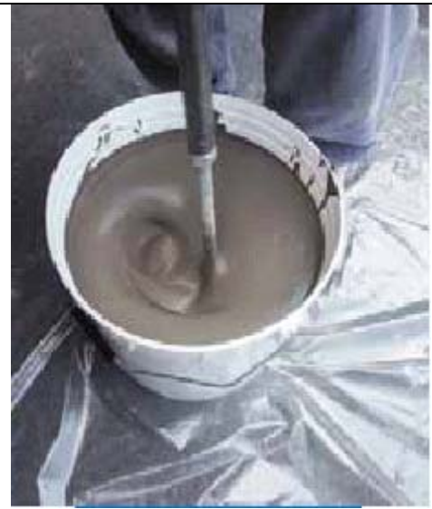
Приготовление состава с использованием дрели
