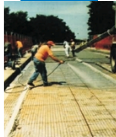
Applying the epoxy primer
