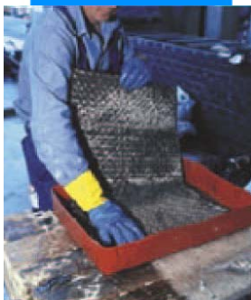
Ручная пропитка покрытия MapeWrap C
