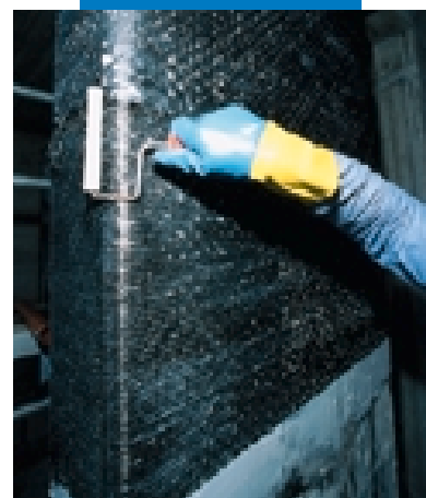
Applicazione della 2ª mano di Mapewrap 31
