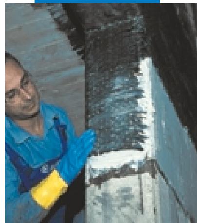
Fasciatura di pilastri e travi
