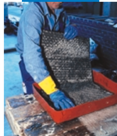
Impregnazione manuale di Mapewrap C
