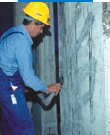
Preparazione del supporto
