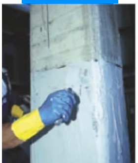
Нанесение шпаклевки Mapewrap 11 или Mapewrap 12
