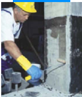
Нанесение Mapewrap Primer 1
