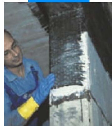
Обвязка колонн и балок
