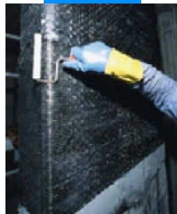
Нанесение второго слоя Mapewrap 31
