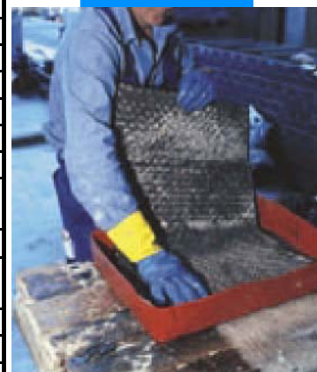
Ручная пропитка покрытия Марепрар С
