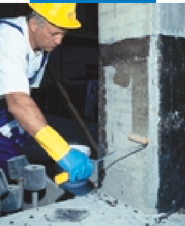
Applicazione di MapeWrap Primer 1
