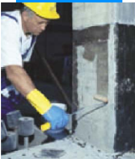
Нанесение Mapewrap Primer 1
