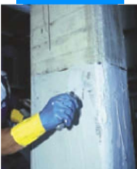
Нанесение шпаклевки Mapewrap 11 или Mapewrap 12
