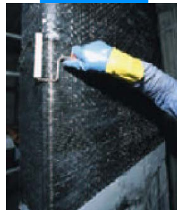
Нанесение второго слоя Mapewrap 31
