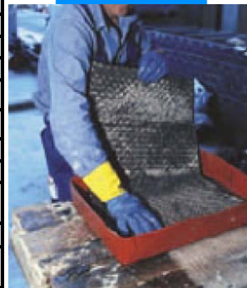
Ручная пропитка покрытия Марепрар C
