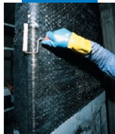
Applicazione della 2ª mano di Mapewrap 31
