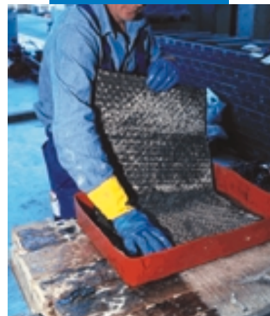
Impregnazione manuale di Mapewrap C
