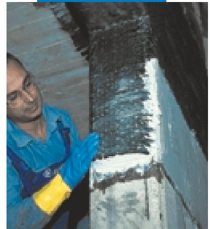
Fasciatura di pilastri e travi
