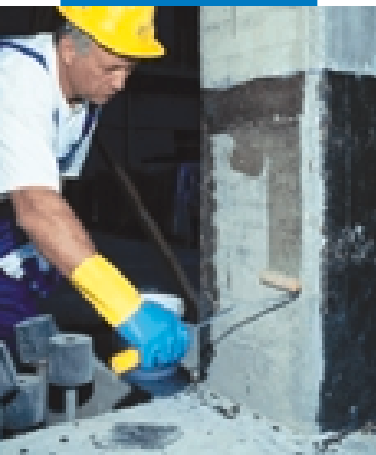
Applicazione di Mapewrap Primer 1
