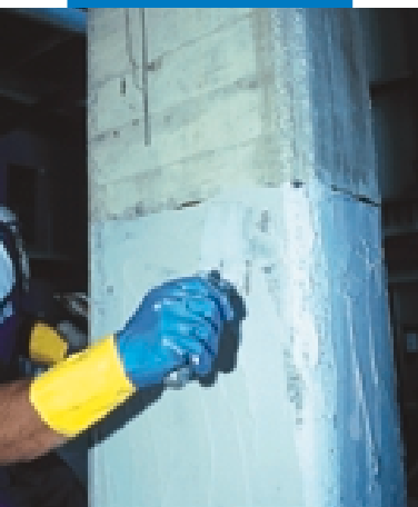
Rasatura con Mapewrap 11 o Mapewrap 12
